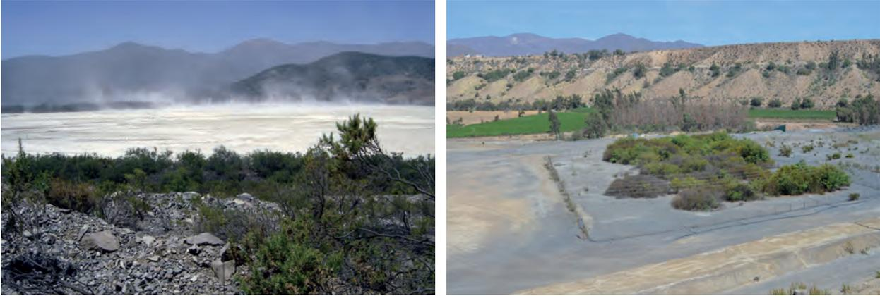
Figura 3. Tranque de relaves post-operativo mostrando erosión eólica de los relaves (izquierda) y después de seis años del establecimiento de un pilotaje de pequeña escala de fitoestabilización asistida (derecha).
